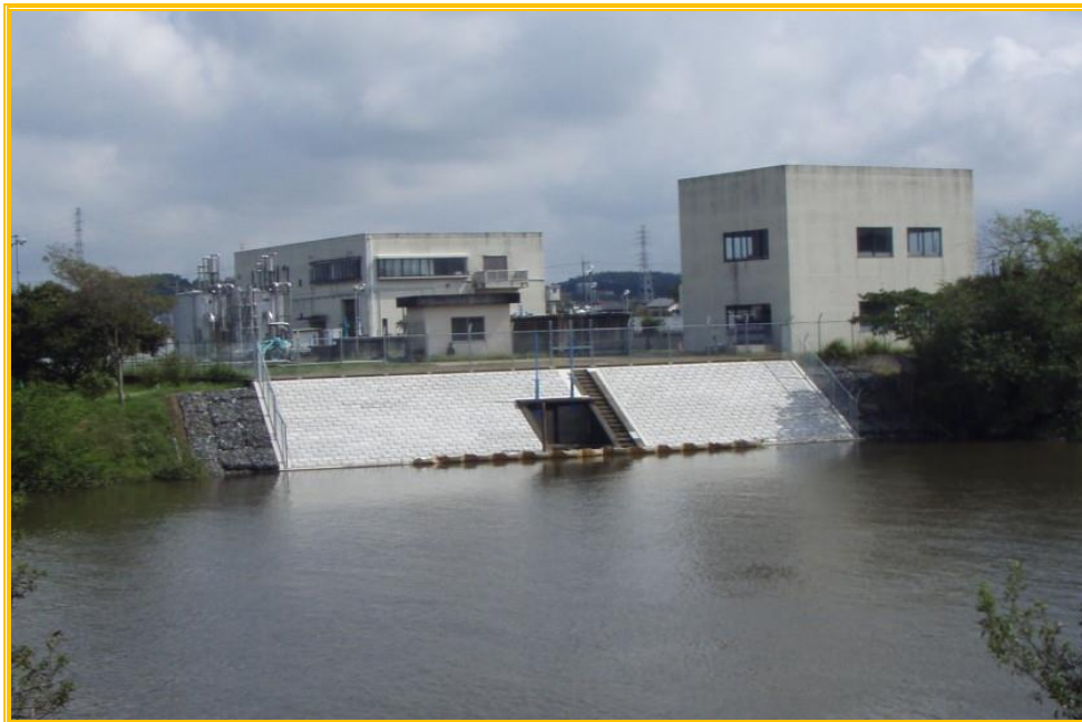
前新田浄水場 取水口
